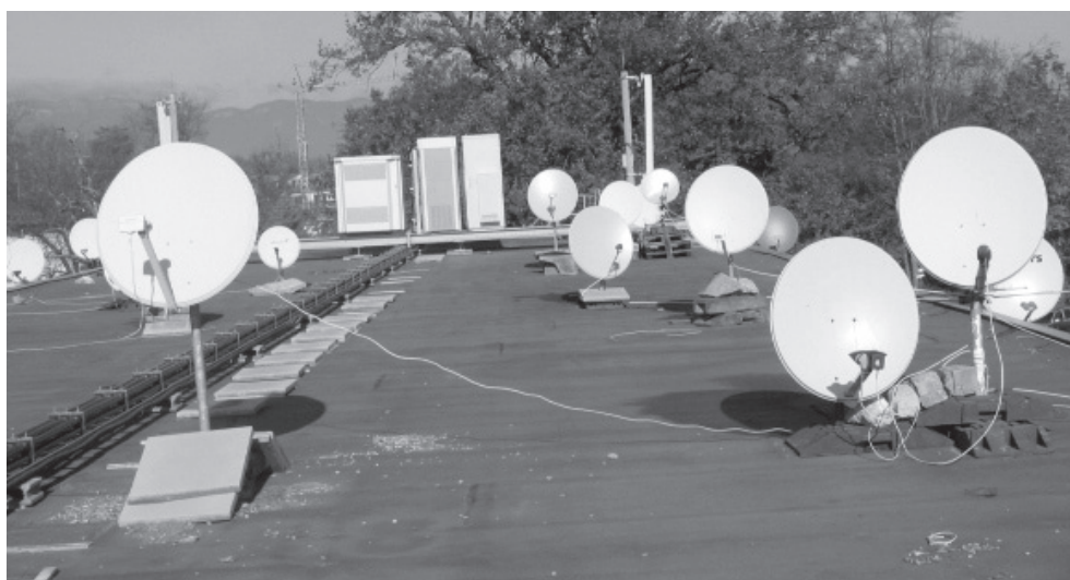
L'engouement pour les antennes paraboliques est visible sur le toit du foyer de Grand-Saconnex (Genève)
